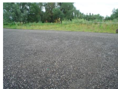
Hlavní vjezd – zpevnění
